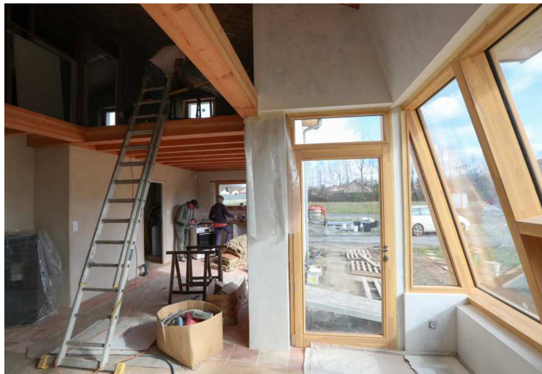
Les travaux battent leur plein pour les premières familles du projet, bientôt prêtes à s'installer. © MARC ZIRNHELD
