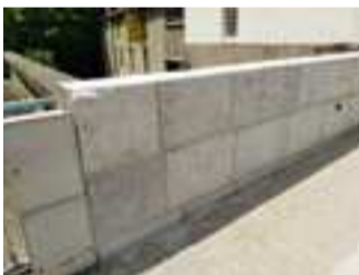
Le garde-corps de la rue Serviez vient d'être réinstallé. © KE
